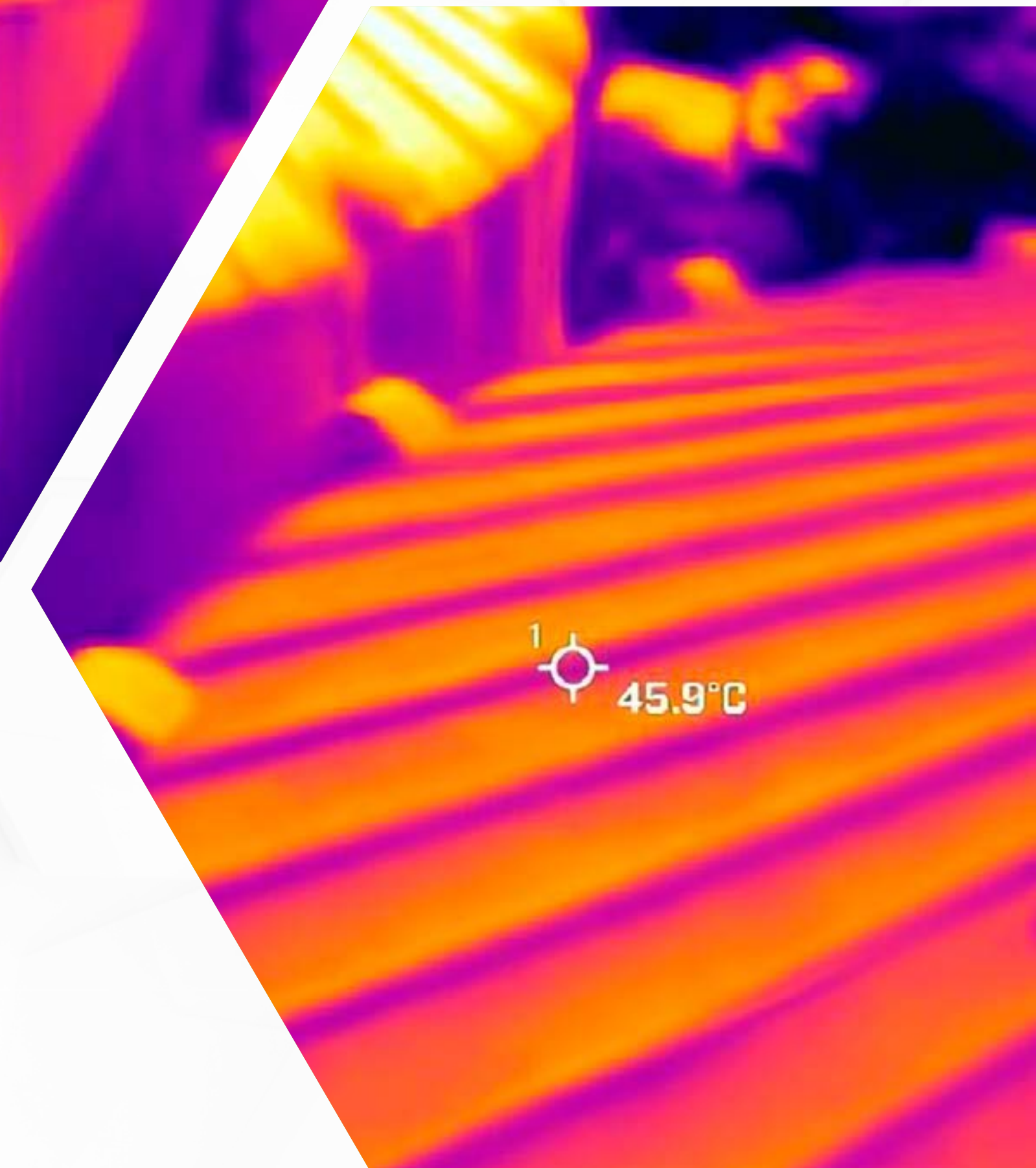
Techo de silos con aislamiento
